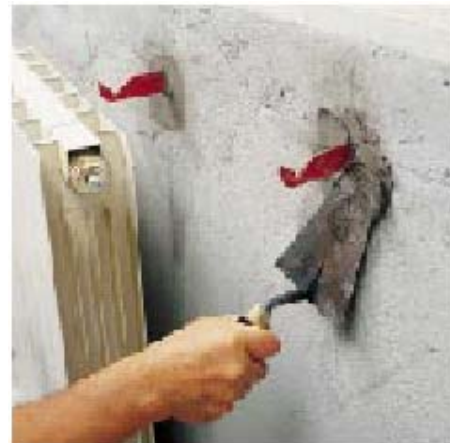
Установка радиатора отопления.
