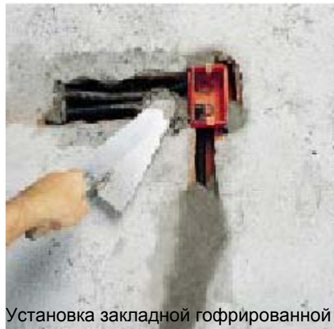
Установка хомутов для крепления труб с помощью LAMPOCEM
